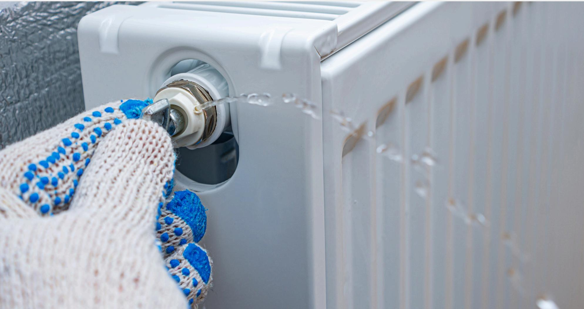
L'un des problèmes les plus courants avec les radiateurs est l'accumulation d'air à l'intérieur, ce qui peut les empêcher de chauffer efficacement. Lorsque de l'air est piégé dans un radiateur, il peut bloquer la circulation de l'eau chaude, rendant certaines parties du radiateur froides au toucher.
